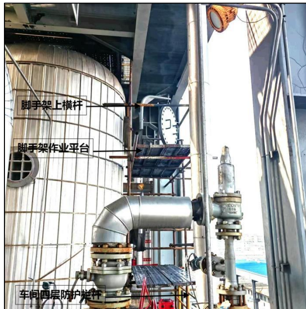
(图3 车间四层脚手架作业平台)
