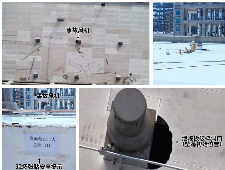
图 2 事故现场 807B 单体内部照片
