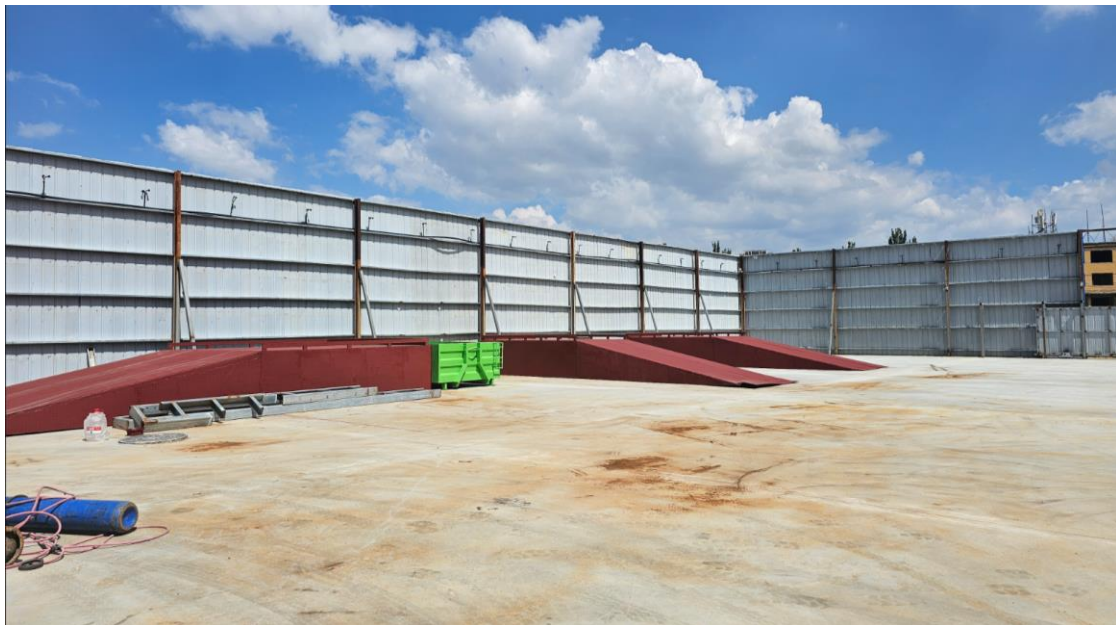
图2-7 九原区装修垃圾分拣转运中心
